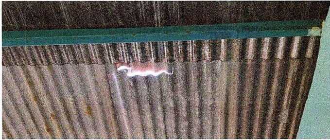
Foto1: Sustitución de láminas en el módulo de las aulas de preprimaria, primero, segundo, tercero, cuarto, quinto y sexto primaria.
