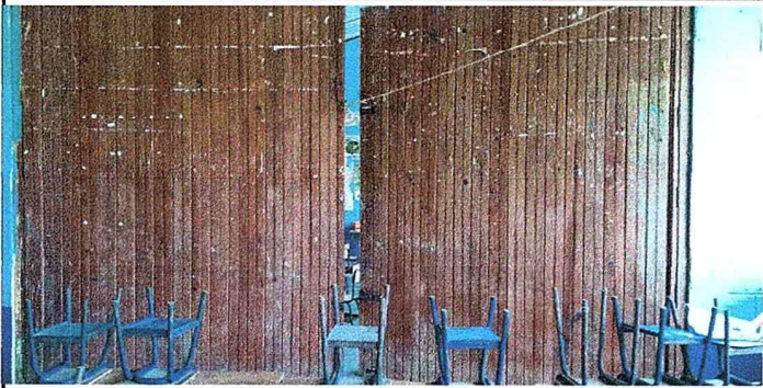
Foto 7: Sustitucion de separacion de aulas de preprimaria, segundo, tercero, cuarto y quinto primaria.
