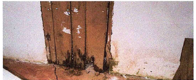
Foto 4: Sustitución de puertas de aula primero primaria.
